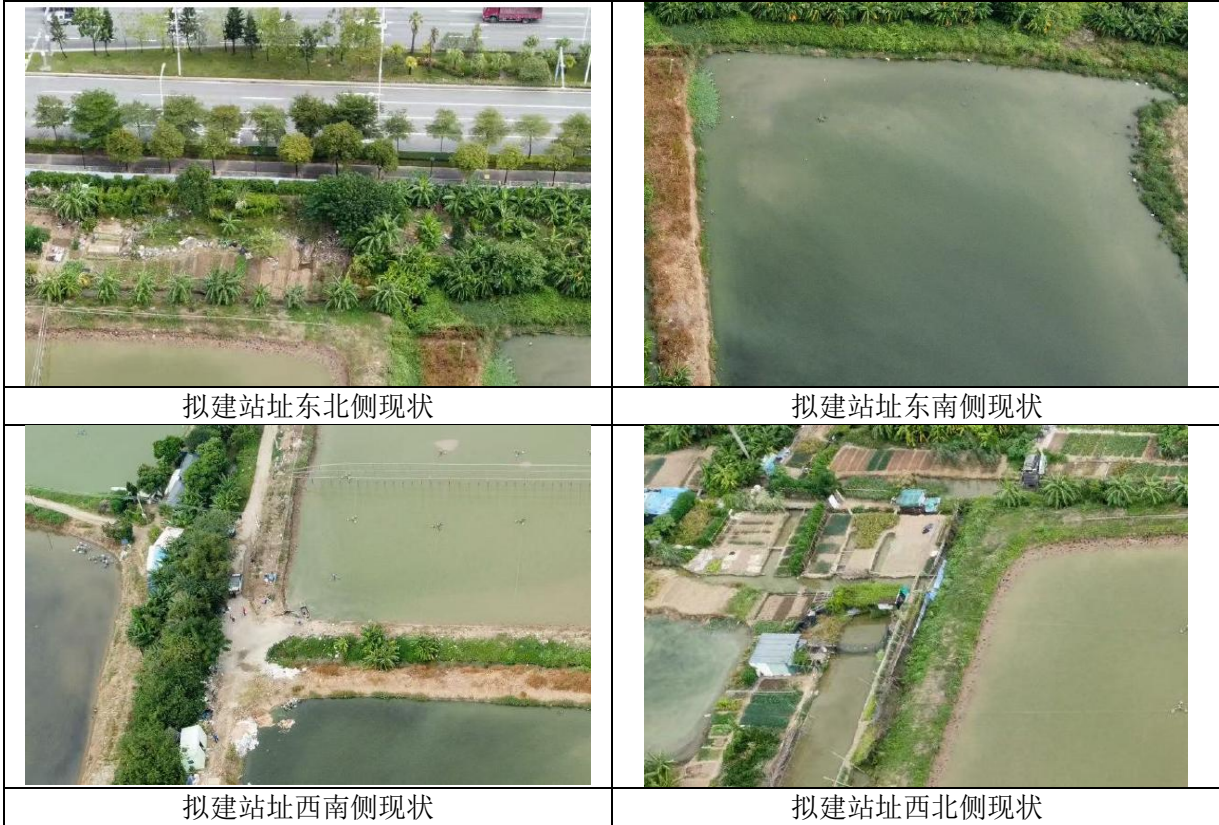
图 2-1 站址现状及四周现状照片
