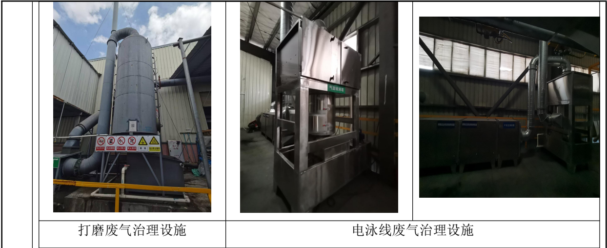
图 2-7 现有工程实拍图
