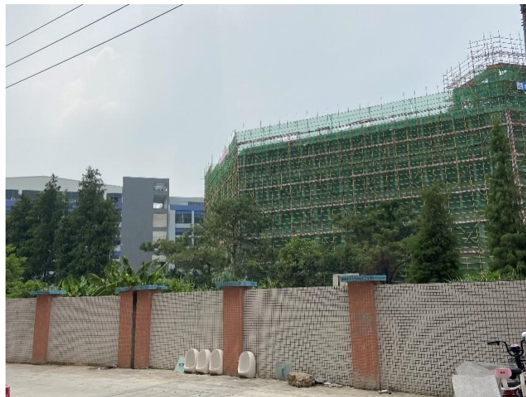
项目南面为在建工地
