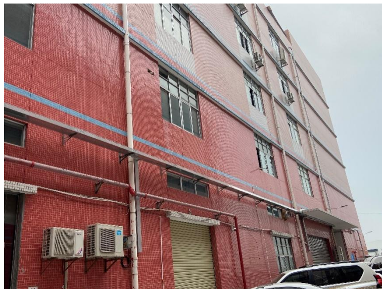
项目北面为江门市奥莉薇雅生物科技有限公司
