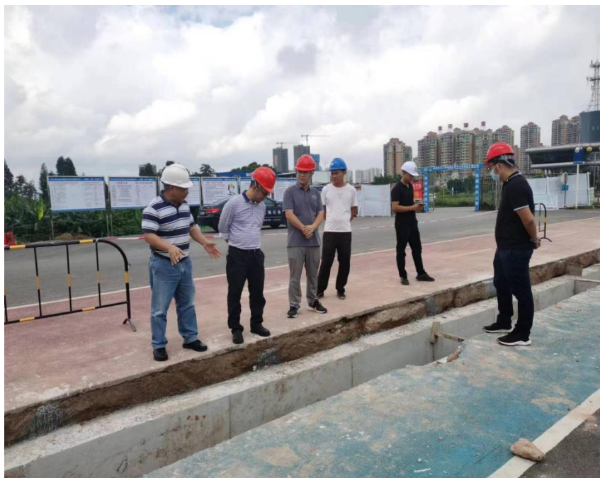
▲图5 郑伟潮同志到在建水利工程施工现场督导安全生产工作
