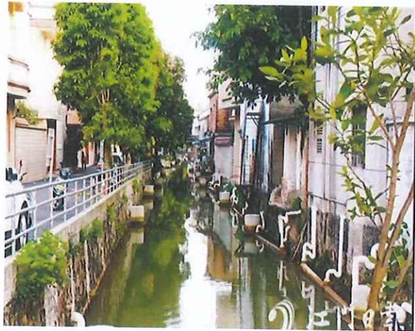
△外海石咀河两岸民居截污管网已全部建好，水体实现不黑不臭。
